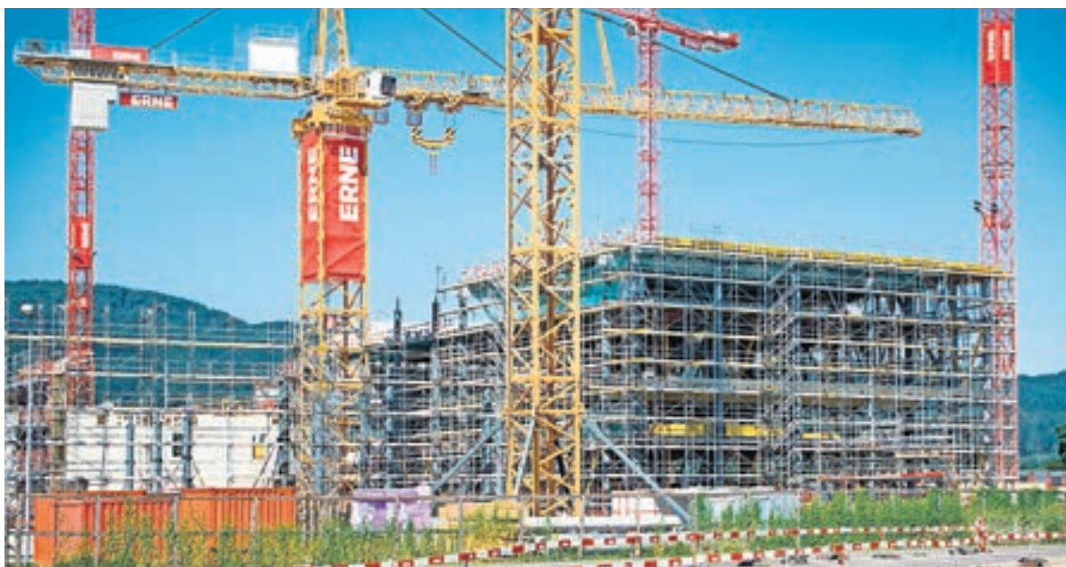
Ohne Korrekturen drohen den St. Galler Gemeinden Verzögerungen bei Bauprojekten.
